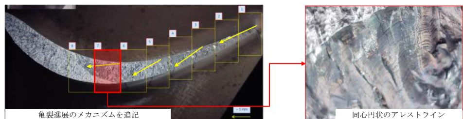
図9 確認された亀裂の状況
