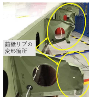
図3 損傷箇所（前縁リブ）
