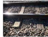
線路設備の修繕
