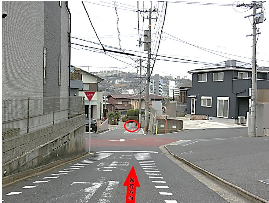
写真 2 - 1 事故地点手前から事故地点（○部分）を望む
