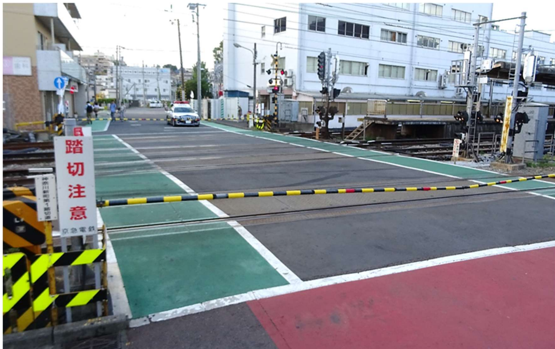
写真9 事故地点の踏切
