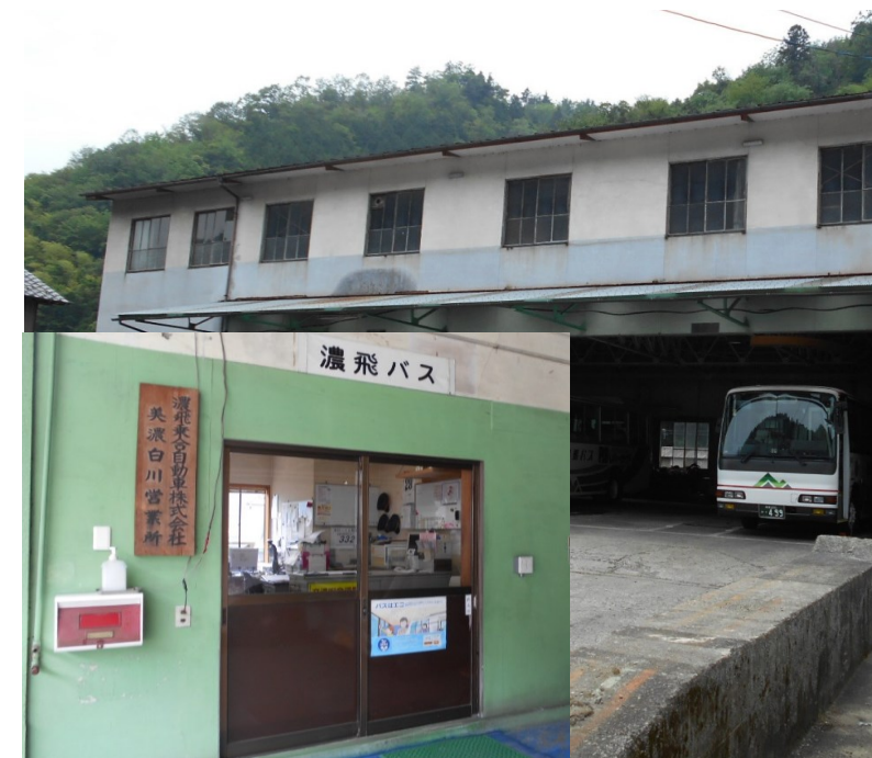
加茂郡白川町河岐字桜地 (平成16年12月移転)
