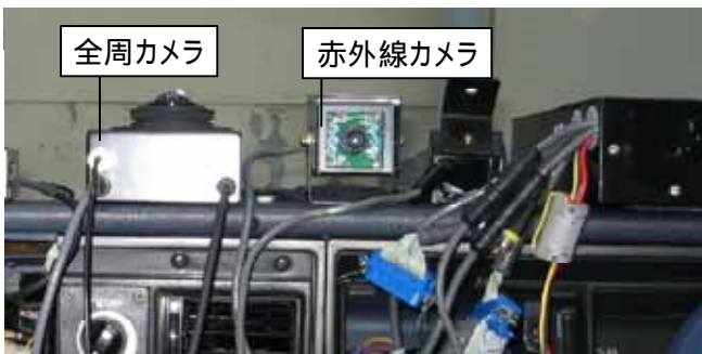
図4 全周カメラ・赤外線カメラの設置状況
