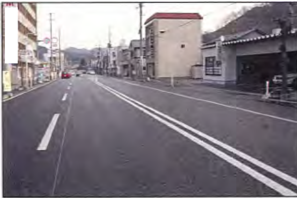
① 事故現場全景 (第1車の進行方向から見た状況)
