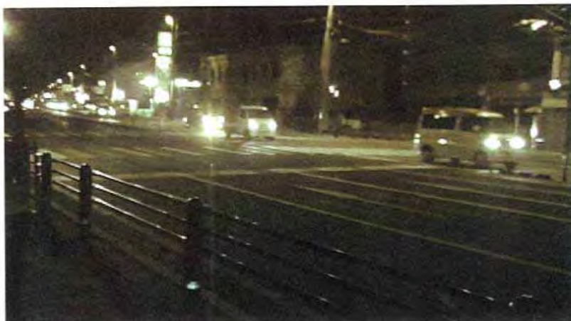
当該事故が発生した場所
