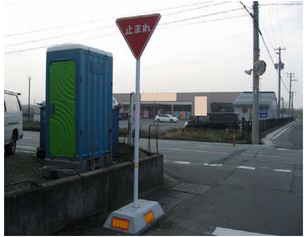
図5 ②道路標識の設置
