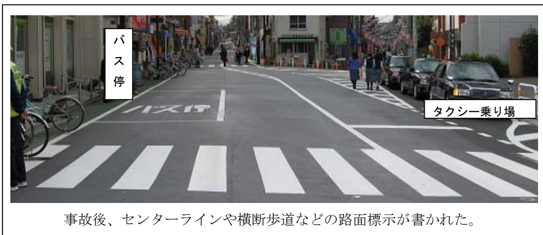
図 1 事故後の道路状況
