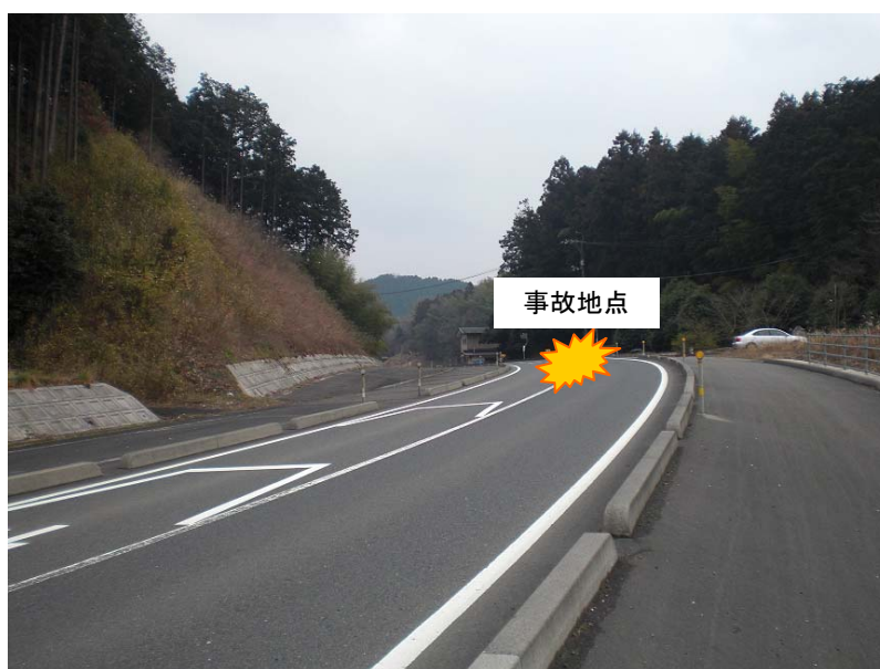
図 1 事故現場の道路状況 （減速マークや文字は事故後に書かれたもの）
