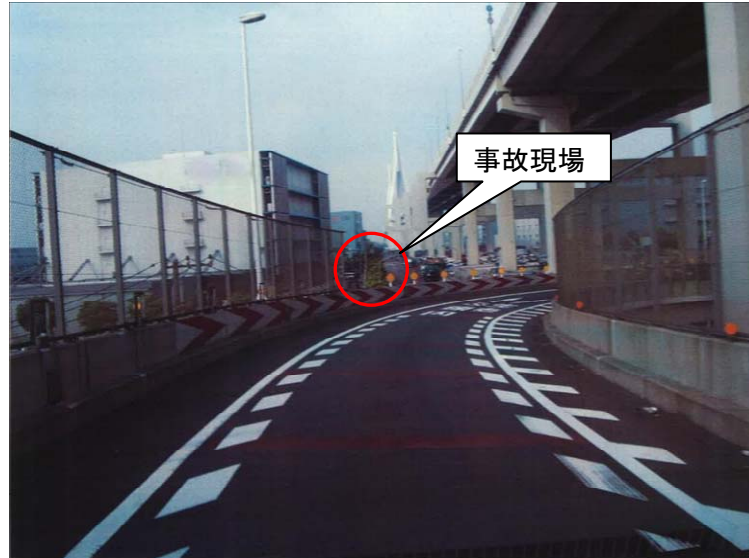
図2 事故現場付近の写真②
