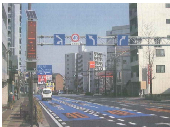
図8 事故現場の写真（改修工事後）
