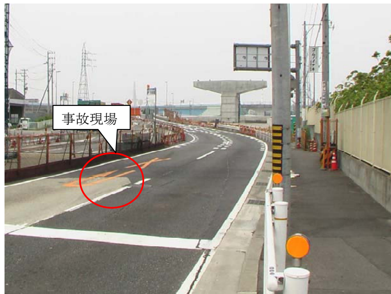
図4 事故現場の写真（改修工事前）
