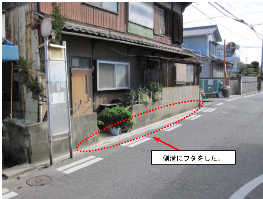
図6 改修後の事故現場 (道の端の側溝にフタをした)
