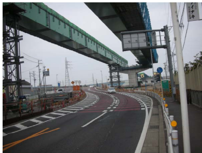
図5 事故現場の写真（改修工事後）
