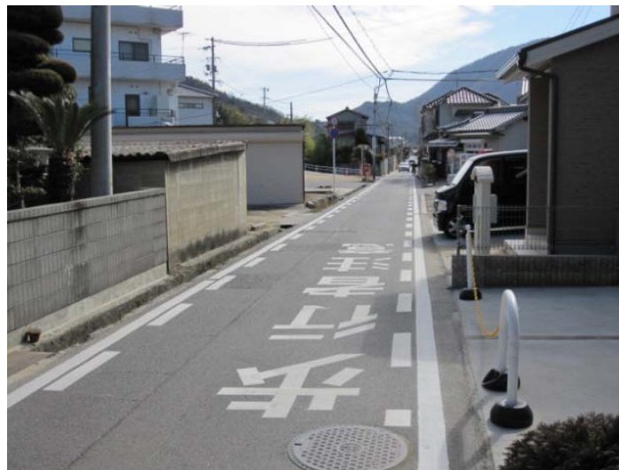
図 8 改修後の事故現場付近（写真の奥に図 7 のポスト） （「歩行者注意」の道路標示があり、路側帯の内側に破線が引かれてある）
