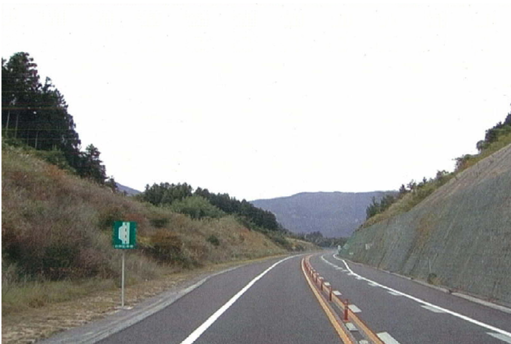
図3 ブレーキ故障現場から火災現場までにある非常駐車帯 (提供:西日本高速道路株式会社)
