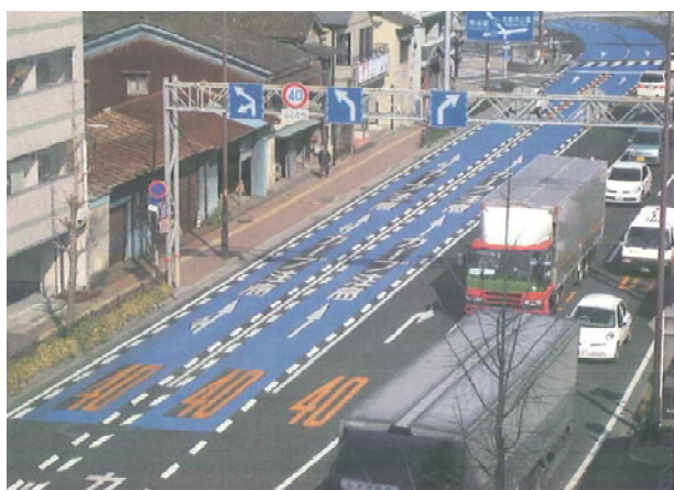
図7 事故現場の写真（改修工事後）
