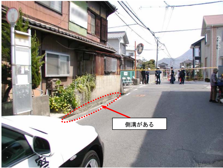
図5 改修前の事故現場 (道の端に側溝がある)
