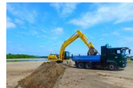
河道掘削状況
