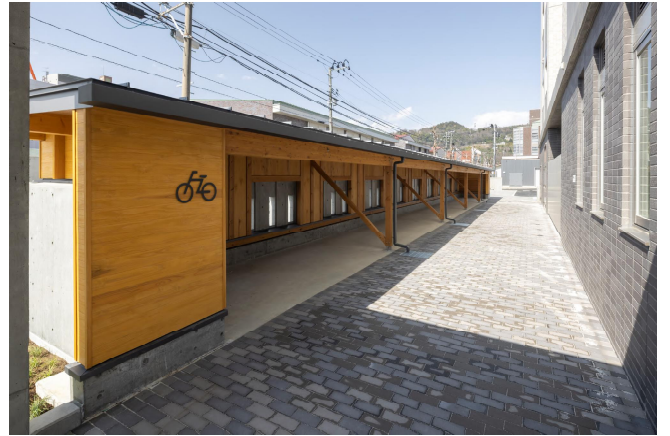
<福島第二地方合同庁舎（自転車置場）>
