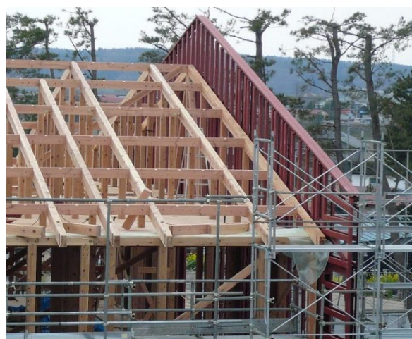
施行中の防火壁
