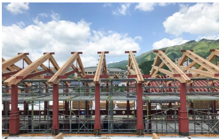
施工中の合成トラス
