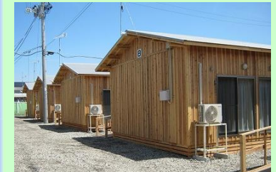
木造仮設住宅（設置例）
