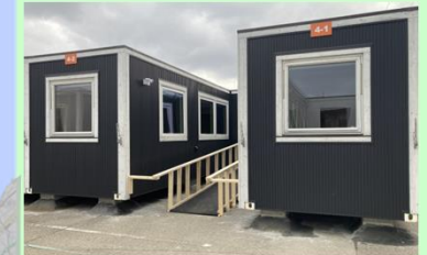
ムービングハウス（輪島市完成例）
