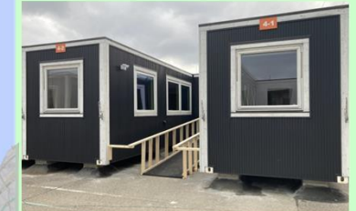
ムービングハウス（輪島市完成例）
