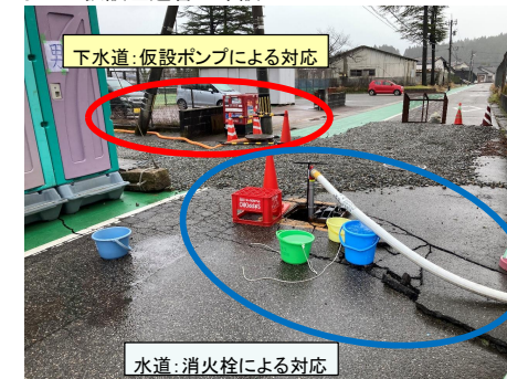
穴水町:仮設ポンプにより流下機能確保(下水道) 消火栓使用により避難所へ給水(水道)
