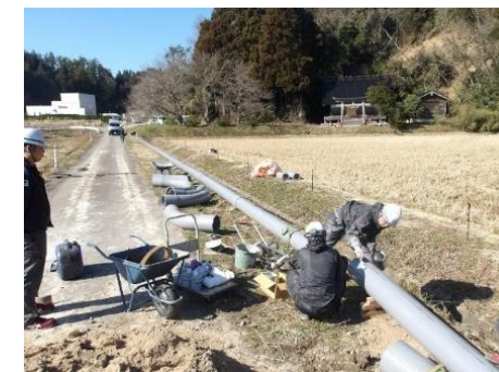
珠洲市:熊谷污水中継ポンプ場から珠洲市浄化センターまでの仮設圧送管の布設
