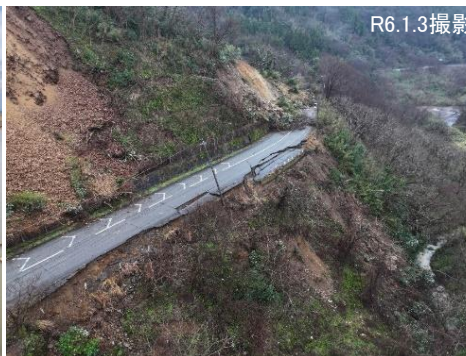
国道249号(羽咋郡志賀町)
