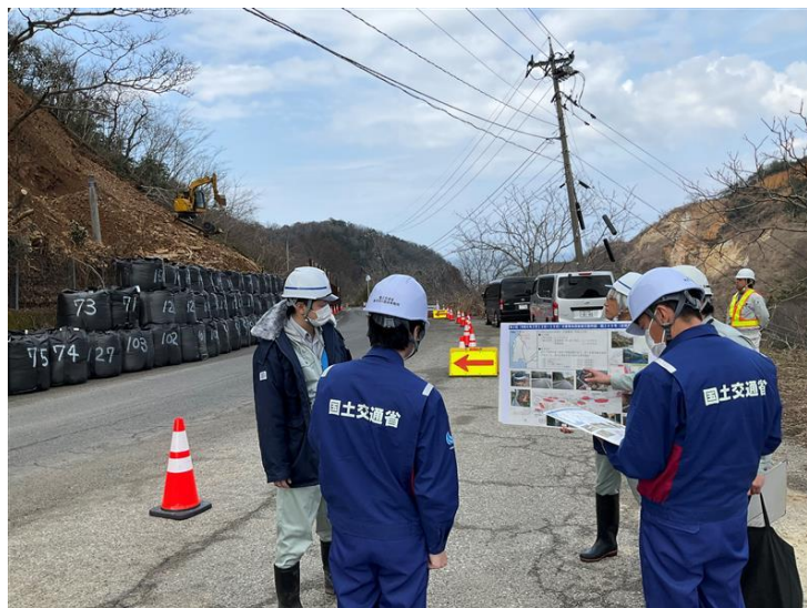
緊急調査状況(国道249号)
