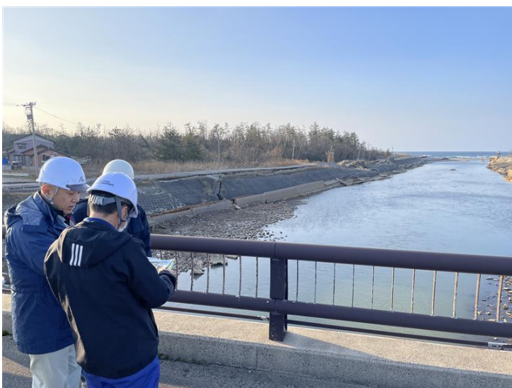
緊急調査状況(二級河川 町野川)
