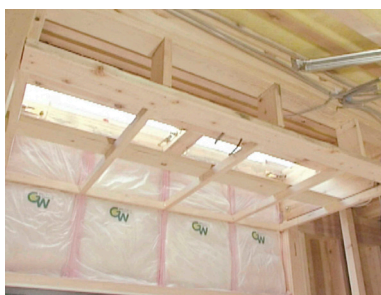
写真 5.7.1 下屋部分の断熱施工前
