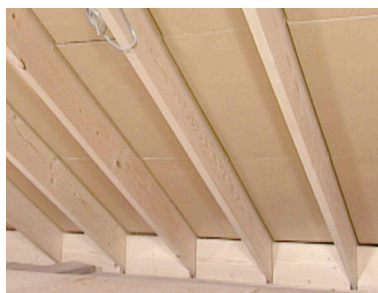
写真 5.6.2 屋根の通気層確保部材（板状）
