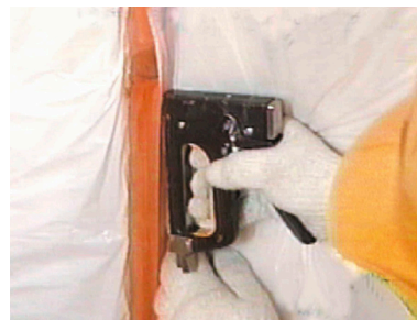
図 5.3.9 防湿フィルムの施工の悪い例 - 1
