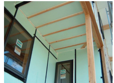
写真 5.2.7 外壁と軒天の断热
