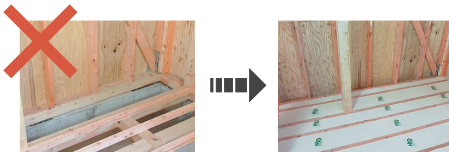
写真 5.2.3 押入れの床の断熱
