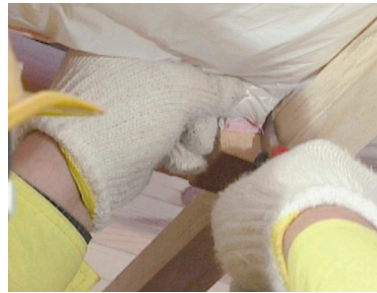
写真 5.5.2 天井の断熱材の施工
