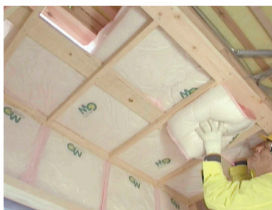
写真 5.7.2 下屋の天井断熱
