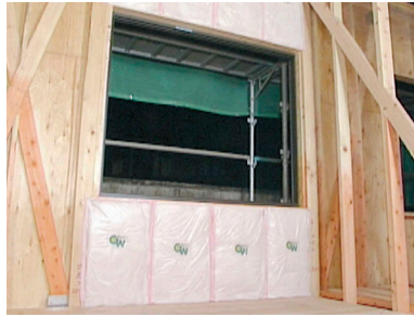
写真 5.4.1 開口部まわりの断熱施工
