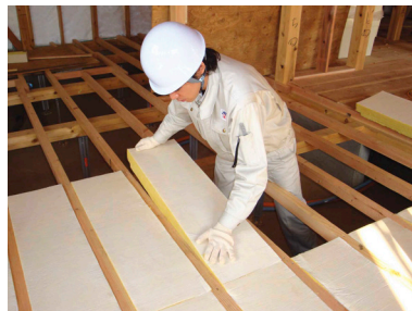
写真 5.2.1 断熱材の切断と施工
