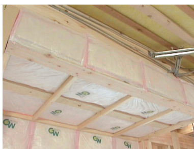
写真 5.7.4 断熱材の施工が完了
