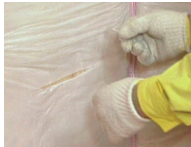
写真 5.3.3 防湿フィルムの補修
