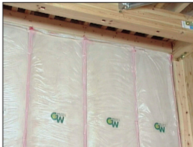
写真 5.3.2 繊維系断熱材の施工
