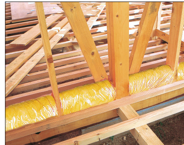
写真 5.2.6 間仕切り壁下の繊維系断熱材の気流止め
