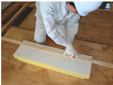
写真 5.2.1 断熱材の切断と施工
