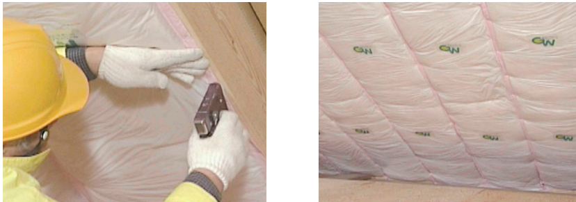
写真 5.6.1 屋根の充填断熱
