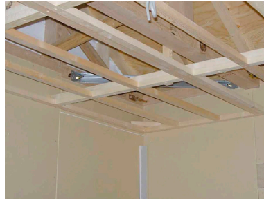
写真 5.5.1 天井の野縁の施工
