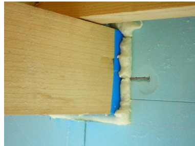
写真 5.3.5 貫通部の断熱補強
