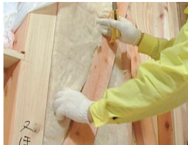
写真 5.3.4 筋かい部分の断熱材の施工
