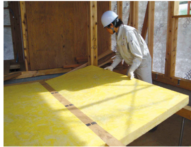
写真 5.2.2 断熱材受け専用金物
