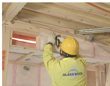
写真 5.7.3 下がり壁の断熱
