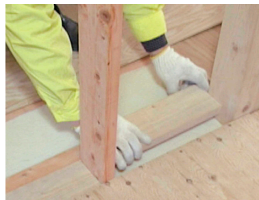
写真 5.2.5 間仕切り壁の下部の気流止め
