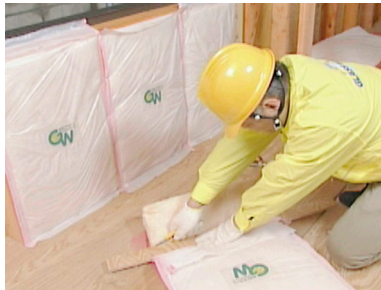
写真 5.3.1 繊維系断熱材の切断
