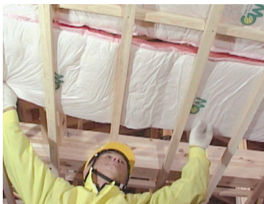
写真 5.5.2 天井の断熱材の施工
