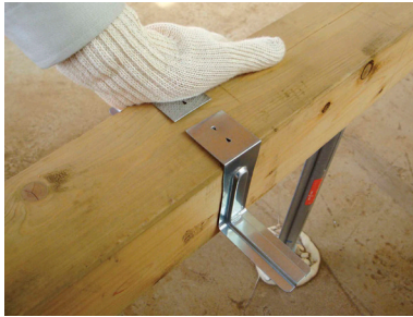
写真 5.2.2 断熱材受け専用金物
