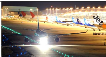
関西国際空港における航空灯火点灯光景（新関西国際空港株式会社提供写真）
