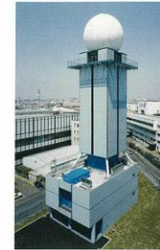
東京国際空港/気象レーダー庁舎（1997年）
