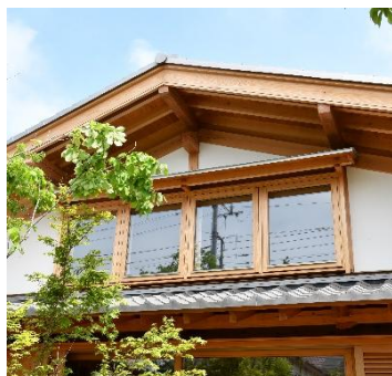
連窓の高窓による通風への配慮
