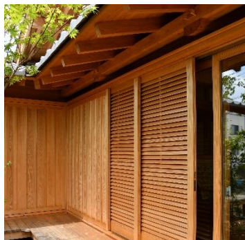
深い軒・庇と多層構成の建具
