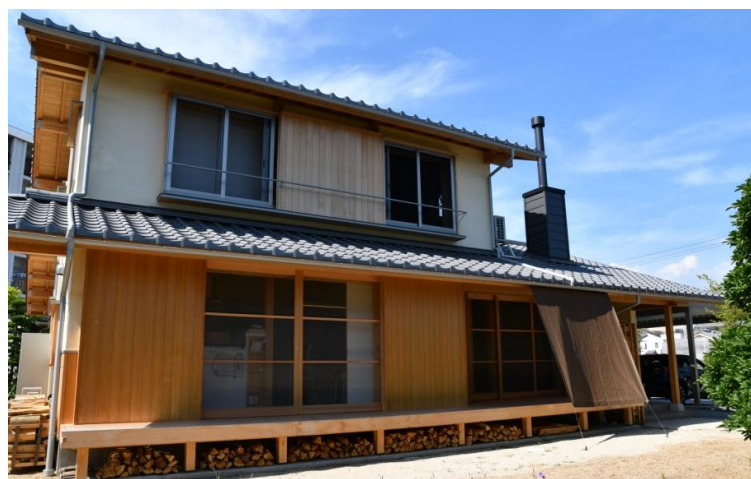
深い軒と広い縁側・大きな開口部がある南側の外観
