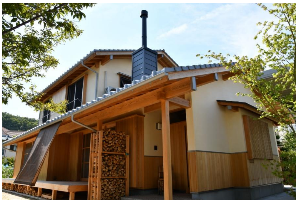
地域の気候特性に配慮した土壁と板壁の組合せをもつ外観
