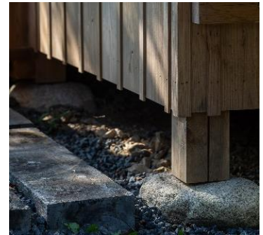
開放的な床下（石場建て）
