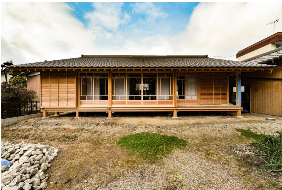
深い軒下空間に連続する大きな窓と縁側
