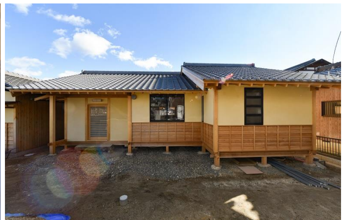
稲わらを使った土壁と板壁で構成されたシンプルな外観
