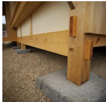
開放的な床下（石場建て）
