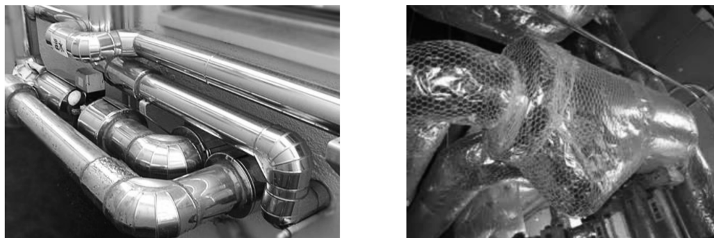
図 2-10 配管保温材の施工
