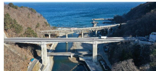
三陸沿岸道路 普代～久慈 (25.0km)開通 (R3.12.18)
