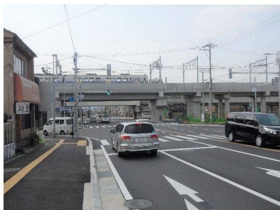
踏切が除却された交差道路
