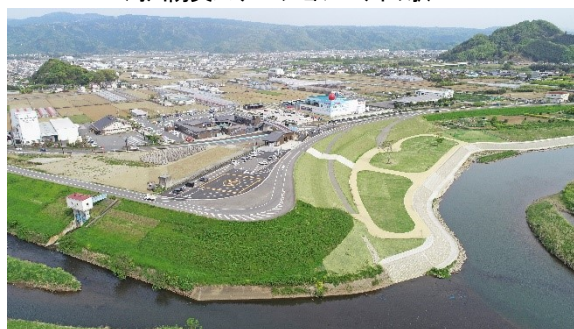
河川防災ステーション・川の駅
