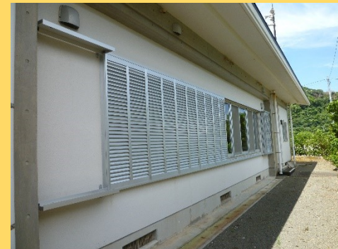
サッシ等の改修
