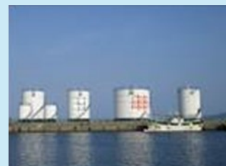
・離島の油槽所
