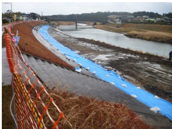
計測対象箇所(終点側)
