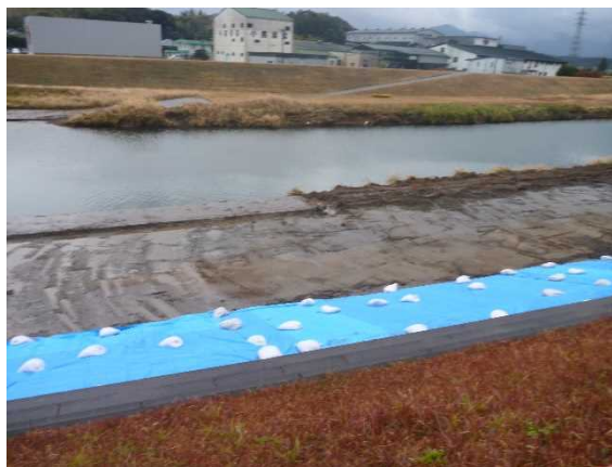
計測対象箇所(平場部)
