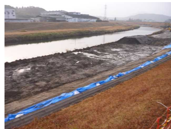
計測対象箇所(終点側)
