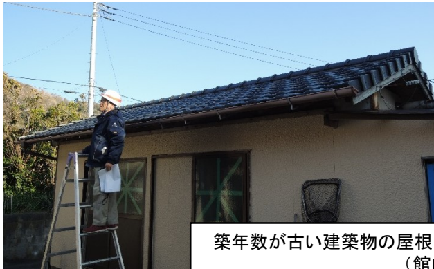
「ガイドライン工法」による瓦屋根の被害事例(館山市西川名)
