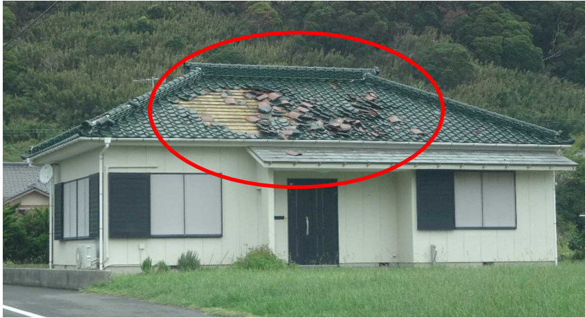
南房総市白浜町(一般部)
