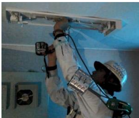
器具付け作業(写真5)
