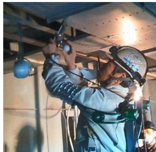
配線のバンド止め作業(写真 4)
