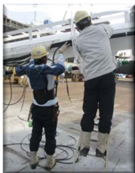
写真9 レーダーマストの結線作業
