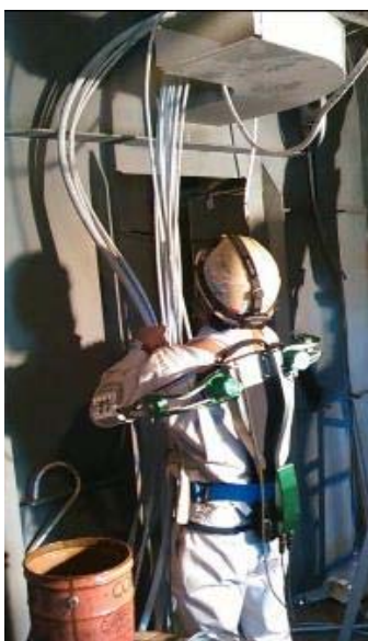
配線持ち上げ作業(写真 3)
