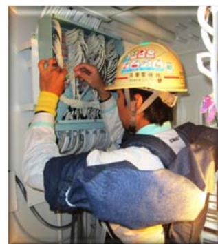
写真11 配電盤結線作業
