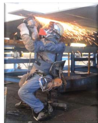
写真 17 ピット内作業
