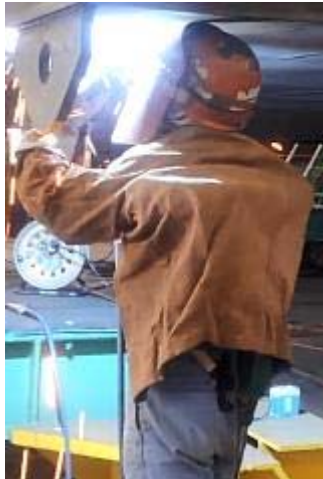
上向き溶接作業(写真 1)
