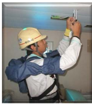
写真10 天井灯結線作業
