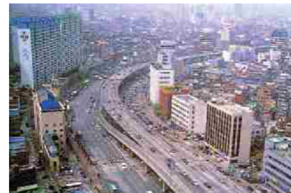
●撤去工事前(2003年4月11日撮影)
