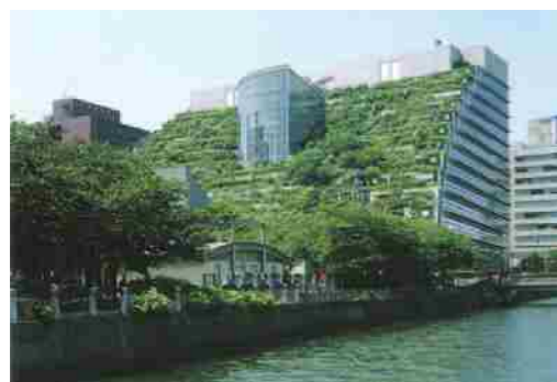
●階段状に緑化を行い、散策路や壁泉などが設けられているアクロス福岡ステップガーデン(福岡県福岡市) (第1回屋上・壁面・特殊空間緑化技術コンクール 国土交通大臣賞受賞)
