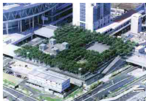
●県民が強い愛着を持つケヤキを人工地盤に植栽した「さいたま新都心」の中核施設であるけやきひろば(埼玉県さいたま市) (第1回屋上・壁面・特殊空間緑化技術コンクール 環境大臣賞受賞)
