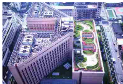
●屋外のリハビリテーション空間として活用している聖路加国際病院(東京都中央区) (第2回屋上・壁面・特殊空間緑化技術コンクール 特別賞受賞)
