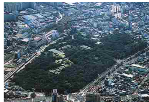
●都市に残された貴重な生物の生息・生育空間としても機能している熱田神宮緑地保全地区(名古屋市)
