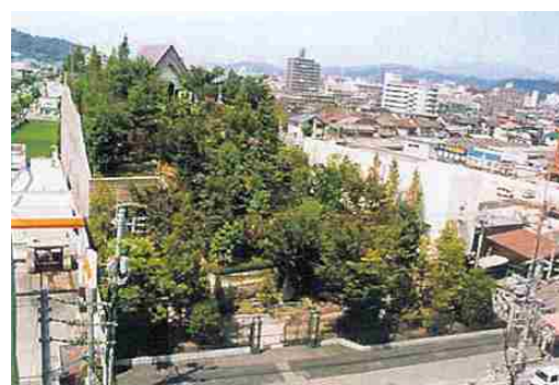
●屋上と庭園が一体となり緑に包まれた空間が創出されているドリーマーベルフォーレ松山「鐘の鳴る社」(愛媛県松山市) (第1回屋上・壁面・特殊空間緑化技術コンクール 日本経済新聞社賞受賞)
