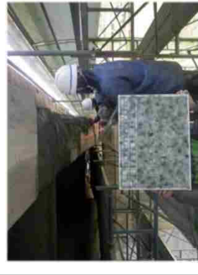
修繕の様子（断面修復）
