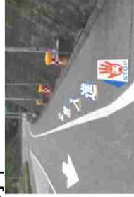
公募技術による逆走対策の展開 （錯視効果を応用した警告表示）
