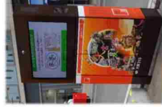
<路上変圧器を活用した デジタルサイネージ> (さいたま市にて実証実験実施中)
