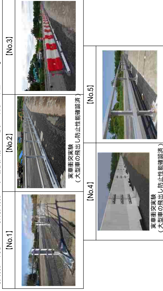
(トンネル・長大橋区間における暫定2車線区間の正面衝突事故防止対策技術の例)
