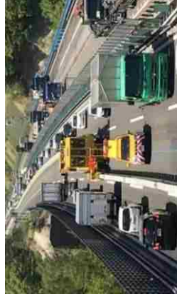
< 移動式防護柵による車線切替状況 >
