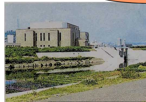
内水排除施設
