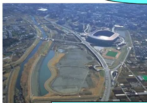
洪水調節施設
