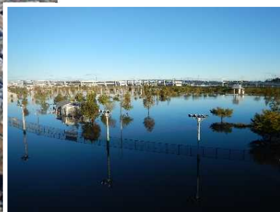
台風第19号時の貯留状況
