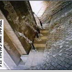
落橋防止構造
