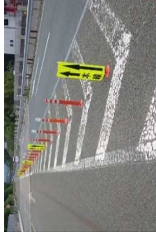
公衆技術による逆走対策の展開 (LED発光体ラバーポールによる誘導)
