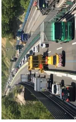
＜移動式防護柵による車線切替状況＞
