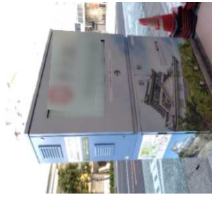
<路上変圧器を活用したデジタルサイネージ> (岐阜県岐阜市にて実証実験実施中)
