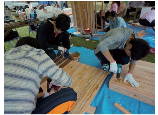
学生によるウッドデッキの製作風景
