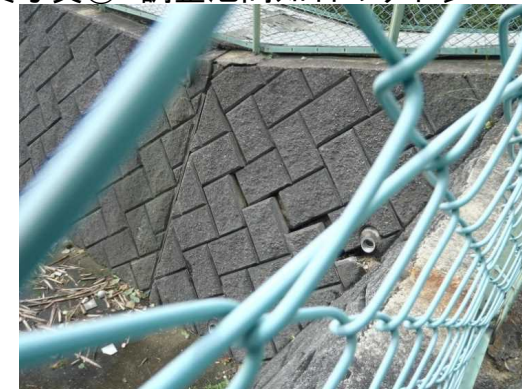
〔写真④ 調整池間知石のずれ〕
