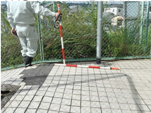
〔写真② 調整池管理通路道路ずれ〕
