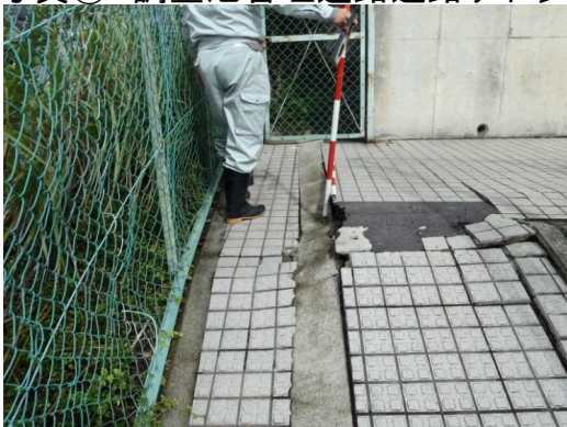
〔写真② 調整池管理通路道路ずれ〕
