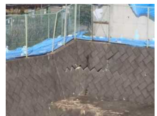
〔写真④ 調整池間知石のずれ〕
