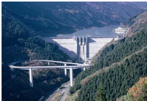
滝沢ダム(水資源機構) H22完成
