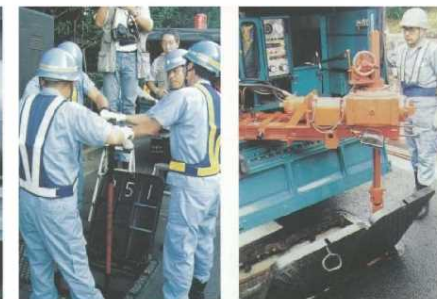
給水バルブの操作状況(東京都)(平成6年)
