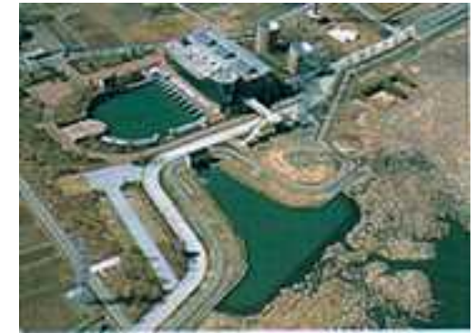
北千葉導水施設(国土交通省) H11事業完了
