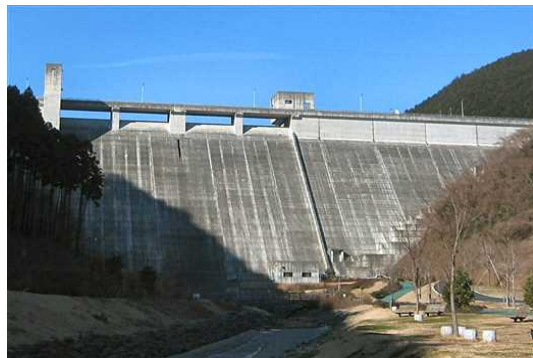
松田川ダム(栃木県) H7完成
