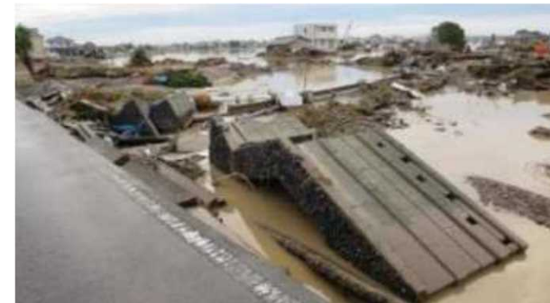
決壊箇所近傍家屋等の流出状況
