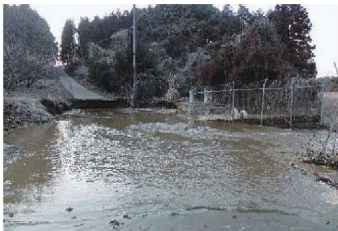
(排泥工:管路内の泥や水を管路外へ排出する設備)
