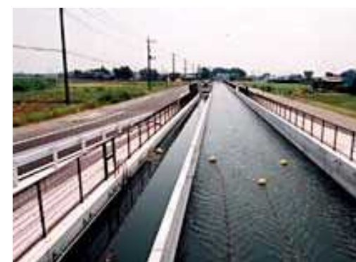
中川水系第一次農業用水合理化施設(埼玉県)
