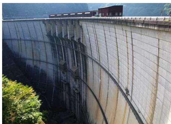
川治ダム(国土交通省) S58完成
