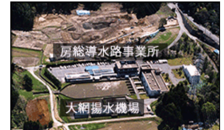
大網揚水機場
