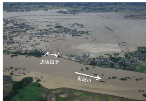
鬼怒川の決壊状況（茨城県常総市三坂町地先）
