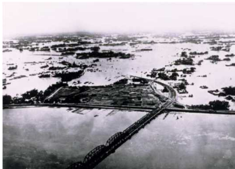
埼玉県栗橋町（現久喜市：利根川）
