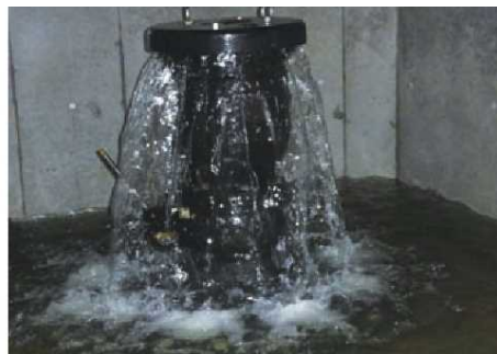
(空気弁:管路内の空気を自動的に排気又は管路内へ吸気する装置)
