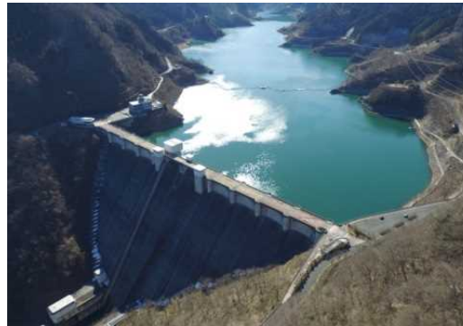
浦山ダム(水資源機構) H10完成
