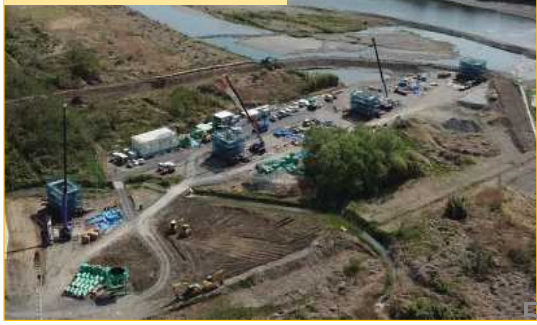
鬼怒川橋りょう区間
