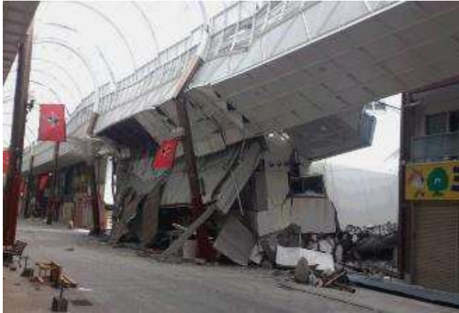
アーケード、建物の倒壊
