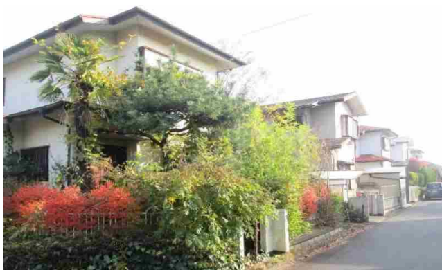
写真2: 道路沿いで放置された空き屋
