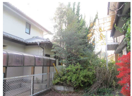
写真3: 樹木の根が隣の家の配管に突き刺さり、支障を来している。
