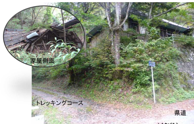
写真1: 道路に隣接する荒廃空き家(下上籠)
