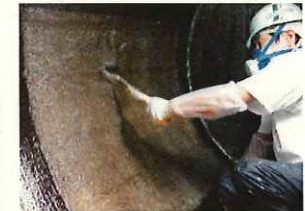
地下タンク内面FRPライニング施工
