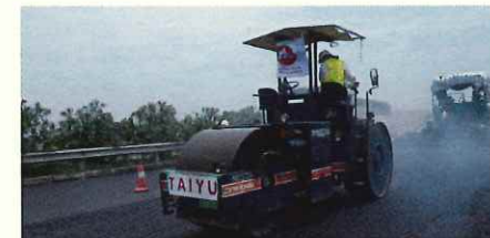
ベトナム試験施工状況 / Trial construction in Vietnam
