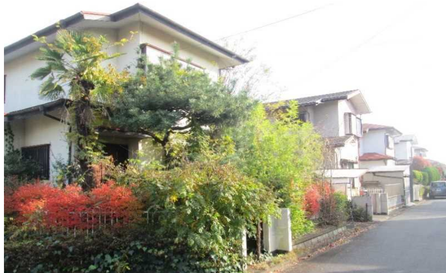
写真2: 道路沿いで放置された空き屋
