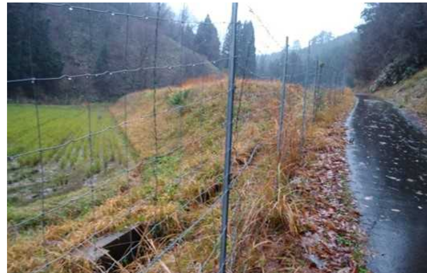
写真3:有害獣対策として、フェンスを設置(近景)
