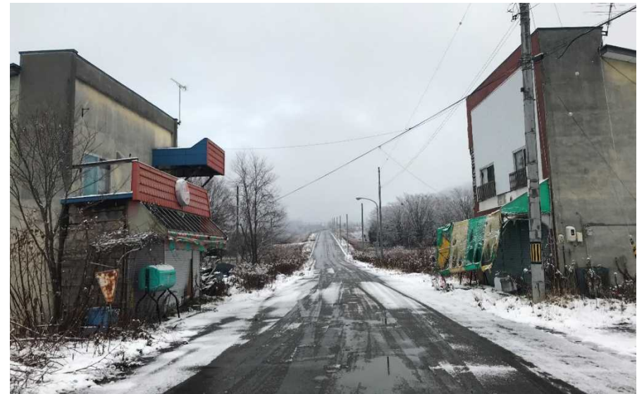
写真1: 道路沿いで放置された空き屋
