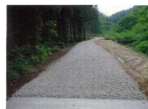
整備後の林業専用道
