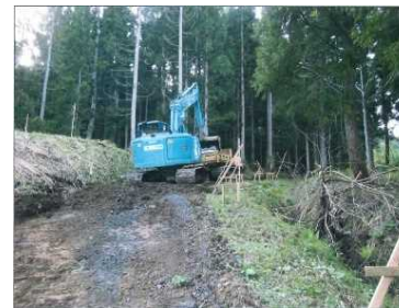
工事中（起点部分）
