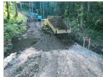
工事中（中間部）
