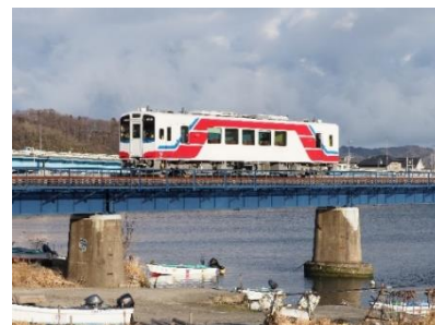
第34伊川橋りょう上を運行する訓練運転車両
