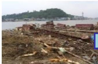
被災直後の鈴木造船所（石巻市）
