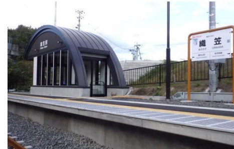
防災集団移転促進事業にあわせ移設した織笠駅
