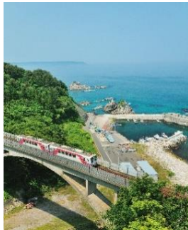
大沢橋りょう上を走行する三陸鉄道車両 (写真提供：三陸防災復興プロジェクト2019実行委員会)
