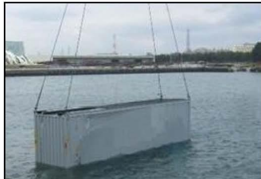
流出したコンテナの除去作業
