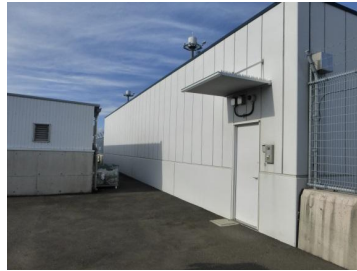
管理事務所車庫・倉庫
