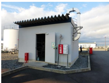
給油施設油脂庫
